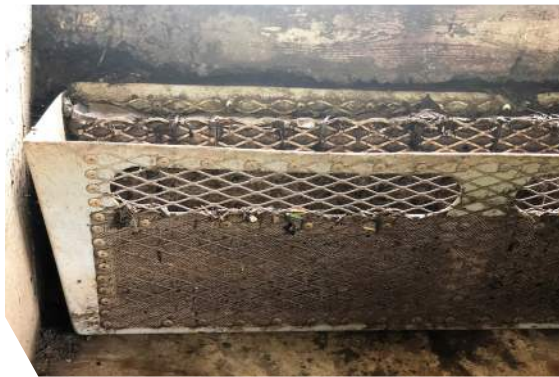
Concrete Sediment Forebay
